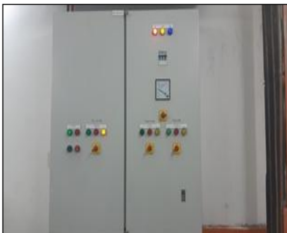
Panel Kawalan Sistem ACPU sistem Aircond berkenaan.
