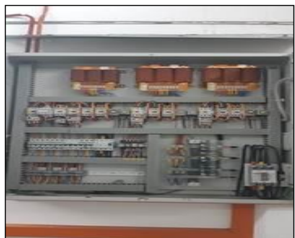
Panel Kawalan Sistem ACPU sistem Aircond berkenaan.
